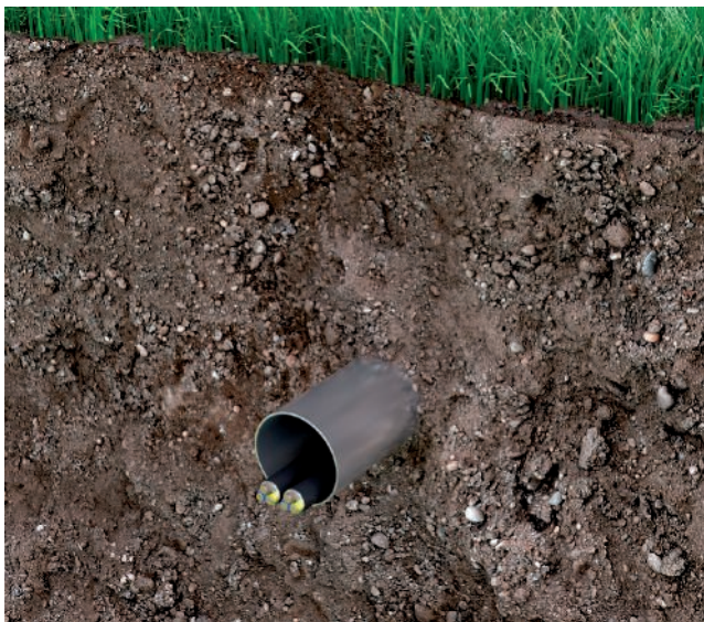
Tendido en tierra
