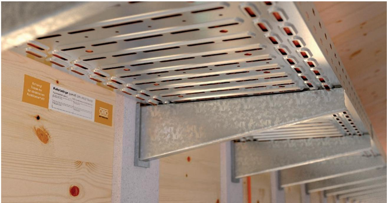
Unter Berücksichtigung der Abbrandraten werden Holzschrauben mit geeignetem Stahlquerschnitt und ausreichender Setztiefe verwendet. Die langen Schrauben dringen tief in den Querschnitt des Holzträgers ein und sorgen trotz Abbrand für einen sicheren Halt der montierten Tragsysteme. Diverse Montagevarianten sind in einem brandschutztechnischen Gutachten dokumentiert.
