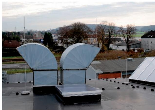
*Getrenntes System mit GFK-Haltern*
