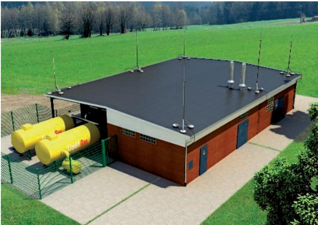
isCon®-Ableitung an Fangmast in Ex-Bereich
