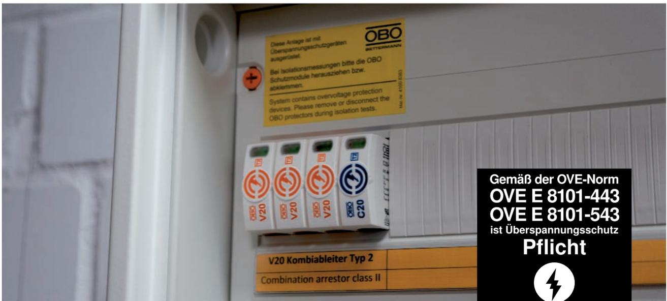
Überspannungsschutzgerät Typ 2 in der Verteilung
