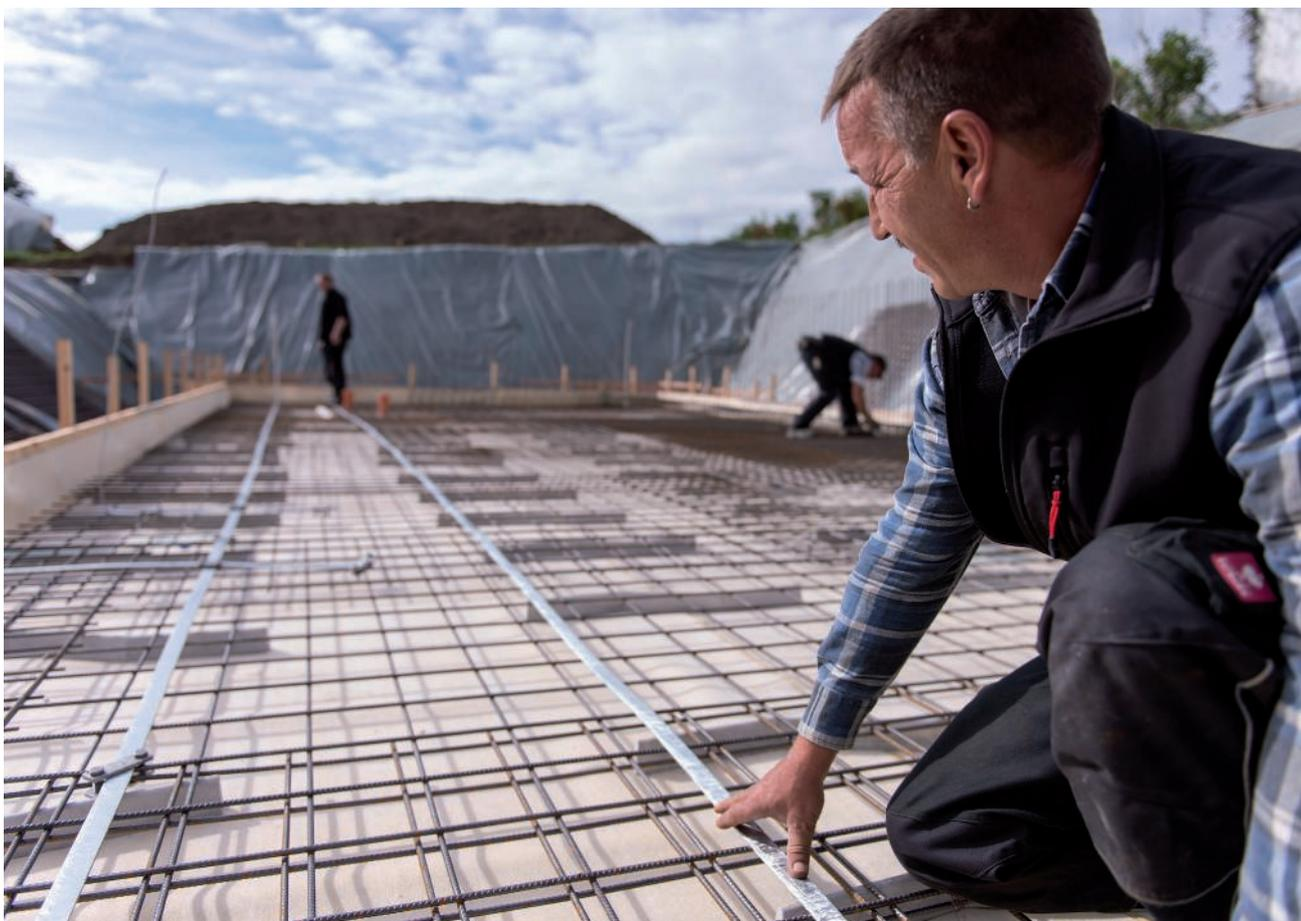
Verlegung eines Fundamenterders
