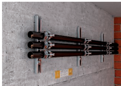
Platzsparende Installation mehrerer Rohre nebeneinander mit Bügelschellen.
