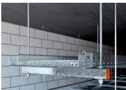
Einlagige Deckenmontage auf Montageschiene.
