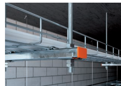
Anschluss der Gewindestange an der Montageschiene.
