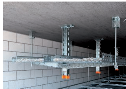
Zweilagige Deckenabhängung mit beidseitiger Auslegeranordnung.
