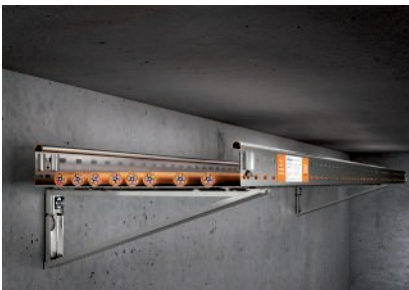
Wandmontage mit Abhängewinkel AHW-T...
