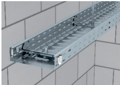
Einsetzen der Mittenabhängung in die Kabelrinne.
