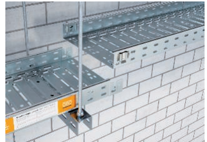
Erstellen der Lngsverbindung durch Ineinanderstecken der Kabelrinne.
