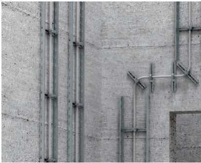
Darstellung Steigeschacht Darstellung einer fertigen Steigeleiternmontage.
