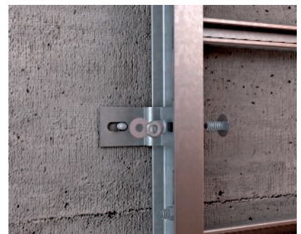
Befestigung Steigeleiter Industrie Wandbefestigung der Steigeleiter Industrie mit Befestigungswinkel Typ BW 80/55.
