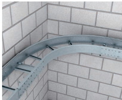
Montage Bogen 90° Bogen in Kombination mit Weitspannkabelleiter. Der Bogen wird mit Außenverbindern mit der Weitspannkabelleiter verbunden.
