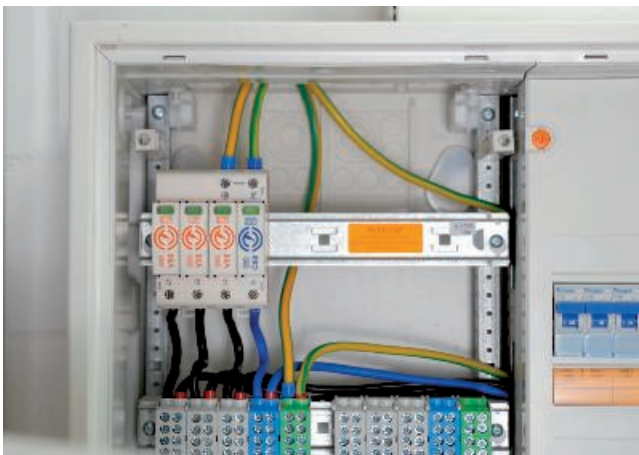
Montage van de type 1+2 combi-afleider V50 in bovenste meteraansluitruimte
