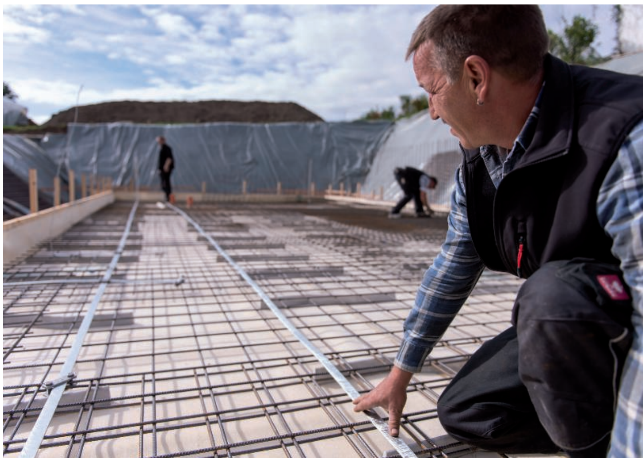
Installatie van een funderingsaarde
