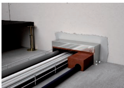
Zugeschnittenen Einlageblock in die größeren Leerräume einbringen
