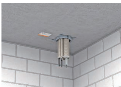
Montage an der Deckenunterseite mit Metalldübeln.
