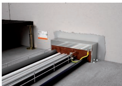
Potentialausgleich anschließen und Kennzeichnungsschild anbringen
