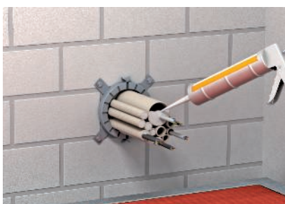
Verschließen der Rohrenden mit Dämmschichtbildner DSX.
