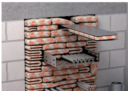
Bleche als Montagehilfe für die letzte Kissensenlage.
