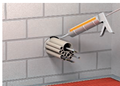
Verschließen der Ringspalte mit Dämmschichtbildner DSX.
