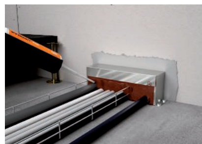
Zwischenräume mit PYROSIT® NG Brandschutzschaum komplett verschließen
