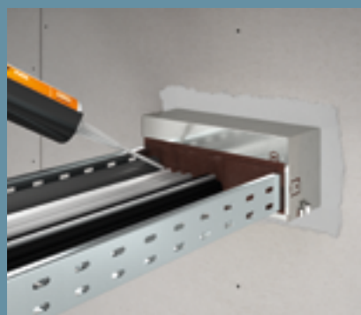
Zwischenräume mit PYROSIT® NG Brandschutzschaum komplett verschließen
