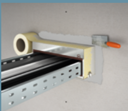
Abkleben und sauberes Einmörteln der Box
