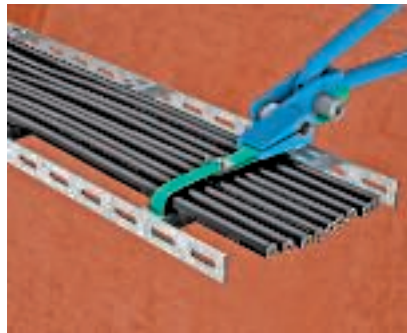
Verspannen Das Ende des Zuschnittes in die Spannzange Typ 576 einlegen und fest verspannen.
