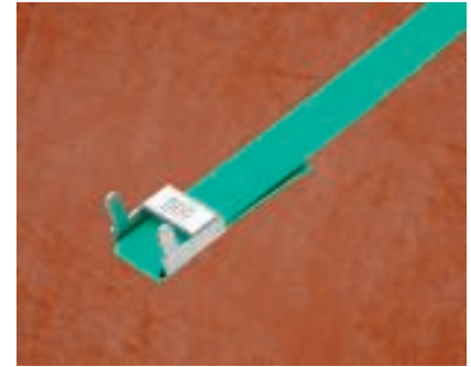
Spannbandverschluss Den Zuschnitt mit einem entsprechenden Spannbandverschluss versehen.
