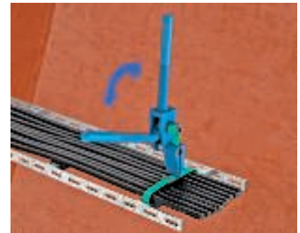
Spannband ablängen Das Spannband umlegen, um ein Herausrutschen zu verhindern und durch Zusammendrücken der Spannzange ablängen.
