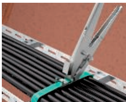
Verspannen Das Ende des Zuschnittes in die Spannzange Typ 575 einlegen und fest verspannen.
