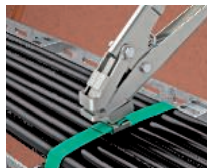
Halteaschen umschlagen Die Halteaschen mittels Zange fest schlagen.
