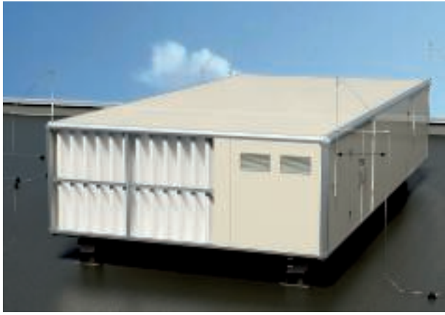
Isolierte Fangeinrichtung mit Trennungsabstand (s)
