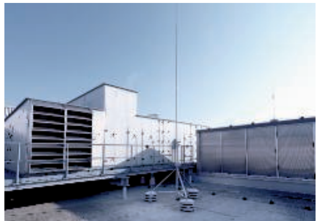
Isolierter Blitzschutz mit isFang
