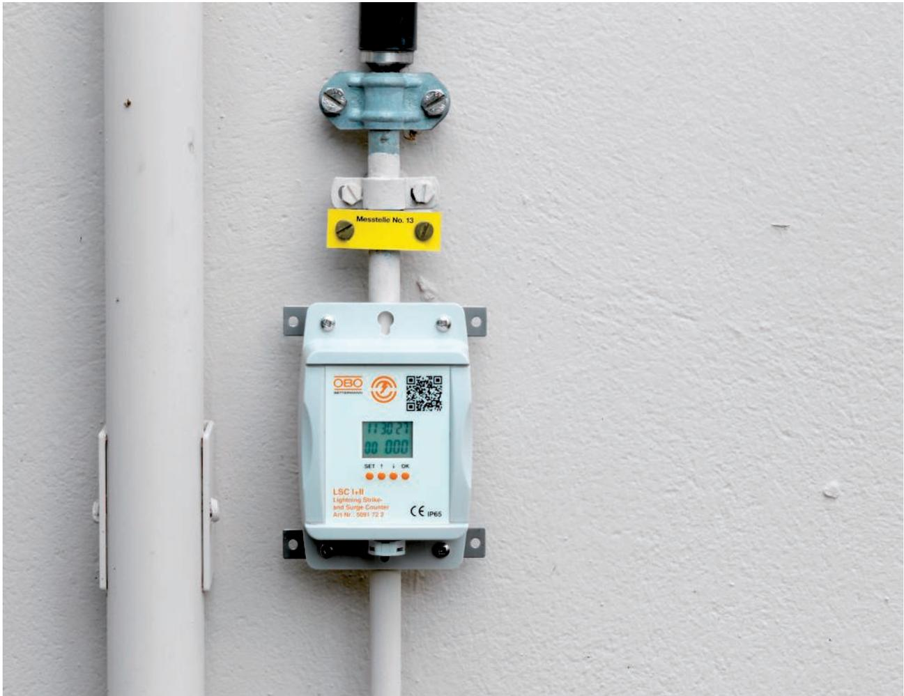
Der Blitzstromzähler LSC I+II erfasst Blitz- und Impulsströme (10/350, 8/20) und speichert dieses Ereignis samt Uhrzeit und Datum fest ab. Somit findet eine ständige Kontrolle statt, ob ein Blitz in das Blitzschutzsystem eingeschlagen hat bzw. ob es zu Überspannungen im System gekommen ist. Ist ein Blitz- oder Überspannungsereignis eingetreten, so muss nach VDE 0185-305 (IEC 62305) das gesamte Blitzschutzsystem gewartet werden.
