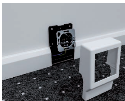
Frontplatte der Abdeckung aufklipsen.
