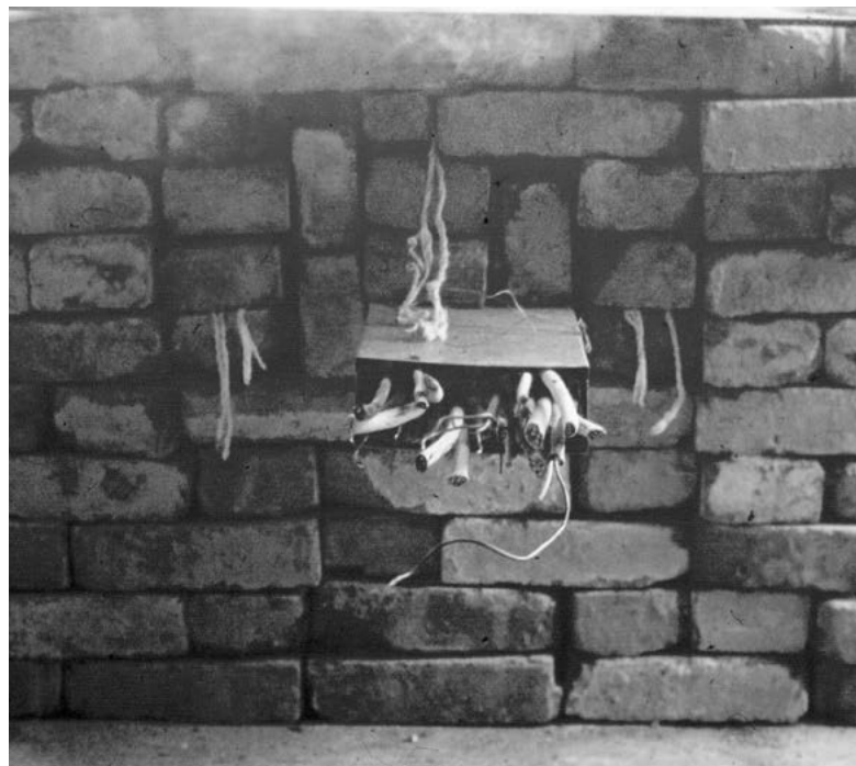
Prüfaufbau der ersten OBO-Kabelabschottung
