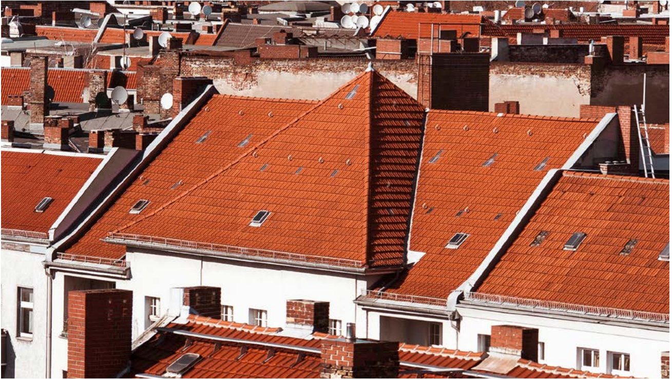
Brandwände verhindern eine Brandausbreitung
