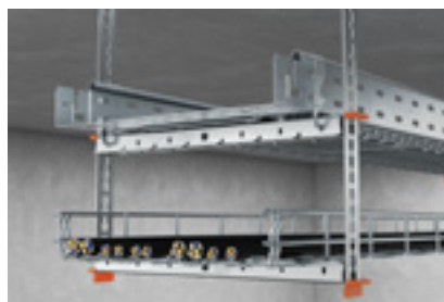
Installationsergebnis der mehrlagigen Pendelabhängung mit Gitter- und Kabelrinne Magic®.
