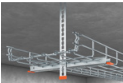
Installationsergebnis der Mittenabhängung einer einzelnen Gitterrinne.
