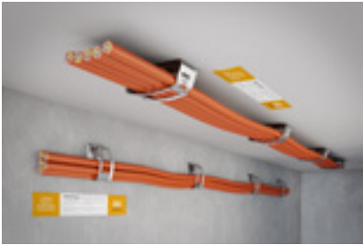
Waagerechte Wand- und Deckeninstallation.
