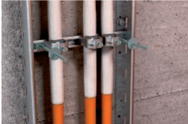
Beschichten der Kabel im Bereich der Zugentlastung
