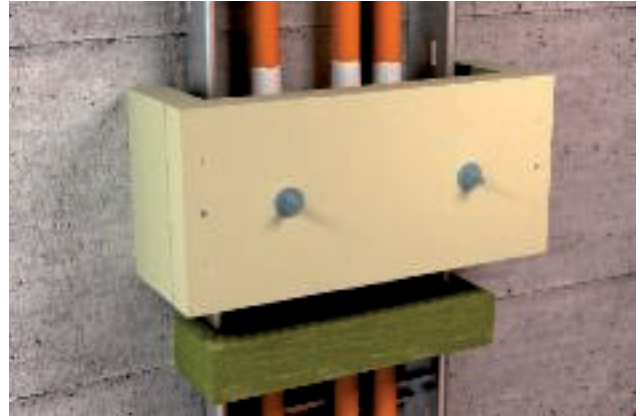
Einbringen der unteren Mineralfaserplatte
