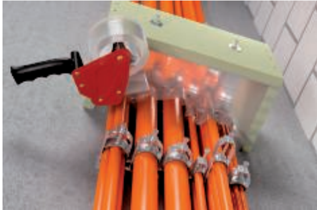
Erstellen einer Schalung zum sicheren Befüllen des Gehäuses
