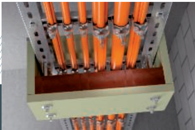
Befüllen des montierten Gehäuses mit Schaumstoffblöcken PYROPLUG® Block
