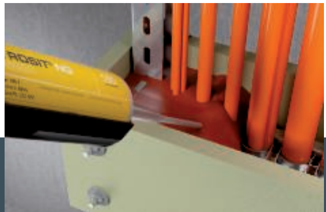
Auffüllen der Kabelzwischenräume mit Brandschutzschaum PYROSIT® NG
