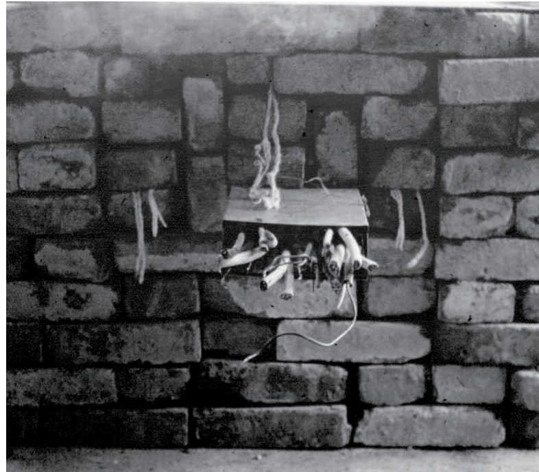
Pirmųjų OBO kabelių sandarinimo priemonių bandymo struktūra
