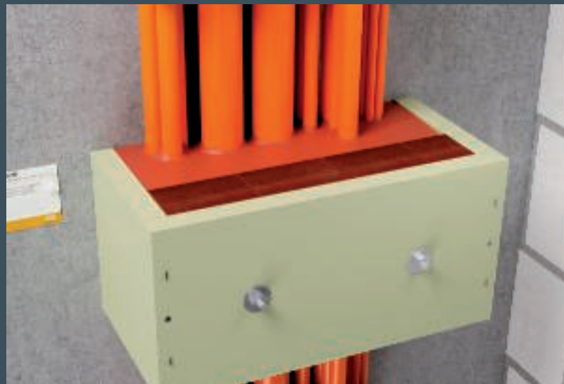
Fertig gefüllte Zugentlastung
