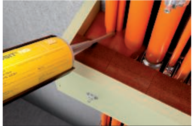
Befüllen mit Schaumstoffblöcken PYROPLUG® Block und Auffüllen der Kabelzwischenräume mit Brandschutzschaum PYROSIT® NG
