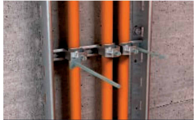
Befestigung mit Gewindestangen und Gleitmuttern in den Sprossen
