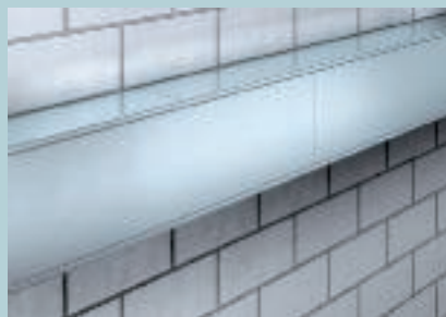
Fugenversatz für mehr Stabilität
