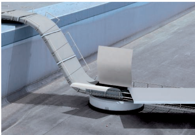
Over de brandwand geïnstalleerde leidingen met bandage
