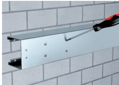
Durchstechen des Brandschutzgewebes im Bereich der Bodenlochung.
