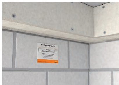
Kennzeichnung nach VDE-Anwendungsregel.
