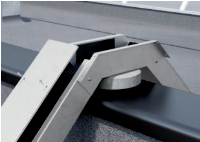
Montage des Kanaldeckels nach der Kabelverlegung.
