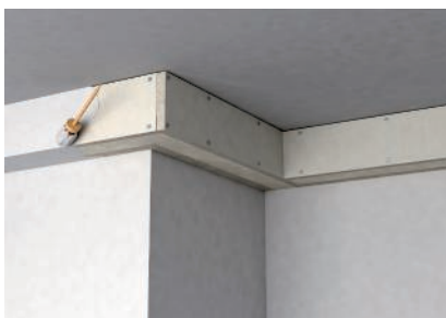
Abschließende Oberflächenbehandlung durch Streichen oder Tapezieren.
