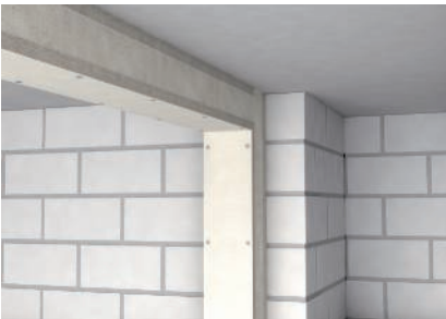
Direkte Wand- und Deckenmontage.
